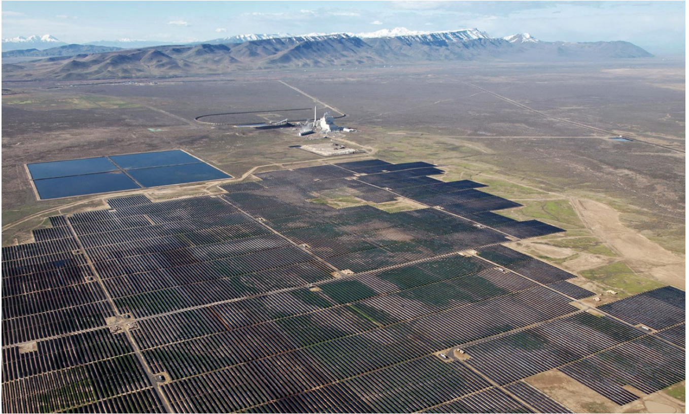
Figura 3. Estrato hegemónico en el paisaje andino. Imagen aérea del Parque Solar Cauchari. Esta infraestructura opera como una “grilla extractiva” (Siegert, 2015), capturando radiación solar para la red de alta tensión nacional e internacional, manteniendo una estricta clausura material frente a las necesidades del hábitat colindante.
