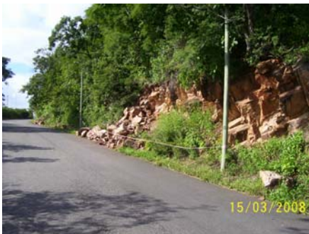
Fotografías 5 y 6. Deslizamientos de taludes de formaciones rocosas de cuarcitas fracturadas, en la fotografía de la izquierda se observa la influencia del agua.
