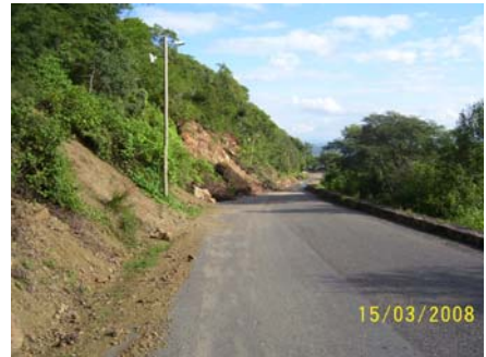
Fotografías 3 y 4. Deslizamientos de taludes de formaciones rocosas de areniscas y suelos. En la fotografía de la derecha se aprecia la influencia del agua.
