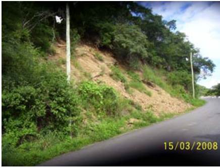
Fotografía 1 y 2. Deslizamientos de taludes en formaciones rocosas lutíticas de dos sectores del camino de acceso al Cerro san Bernardo.
