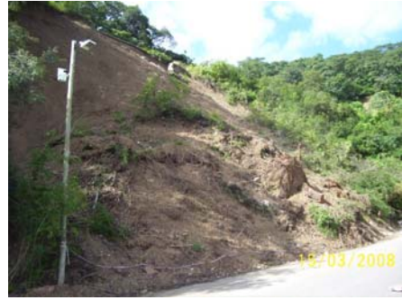
Fotografía 1 y 2. Deslizamientos de taludes en formaciones rocosas lutíticas de dos sectores del camino de acceso al Cerro san Bernardo.
